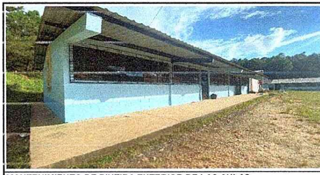
MANTENIMIENTO DE PINTURA EXTERIOR DE LAS AULAS
