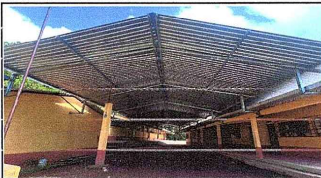
ENTECHADO DEL CORREDOR CON LAMINA TROQUELADA
